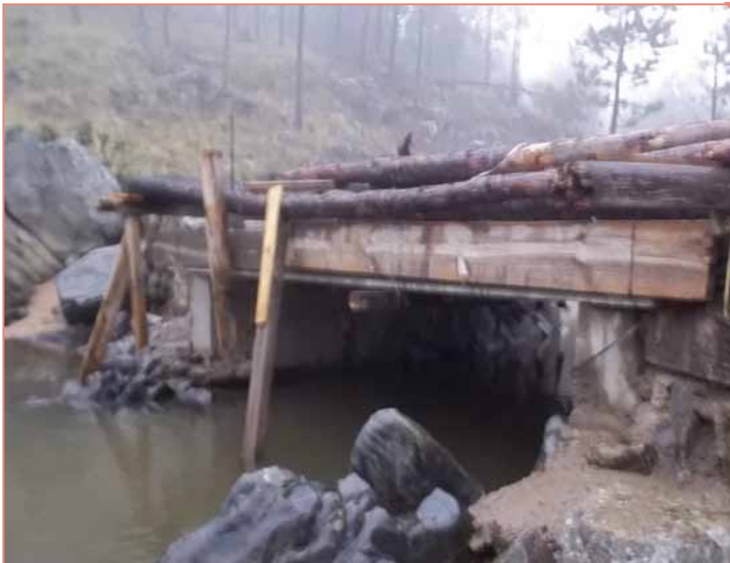
Figura 25. Puente de madera.
