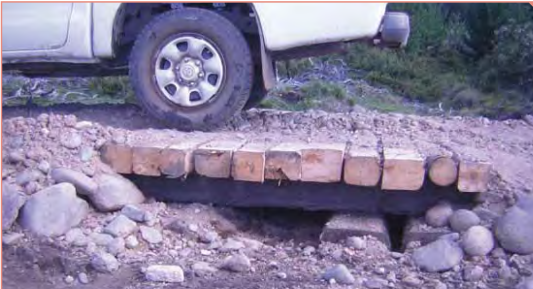
Figura 22. Obra de drenaje.
