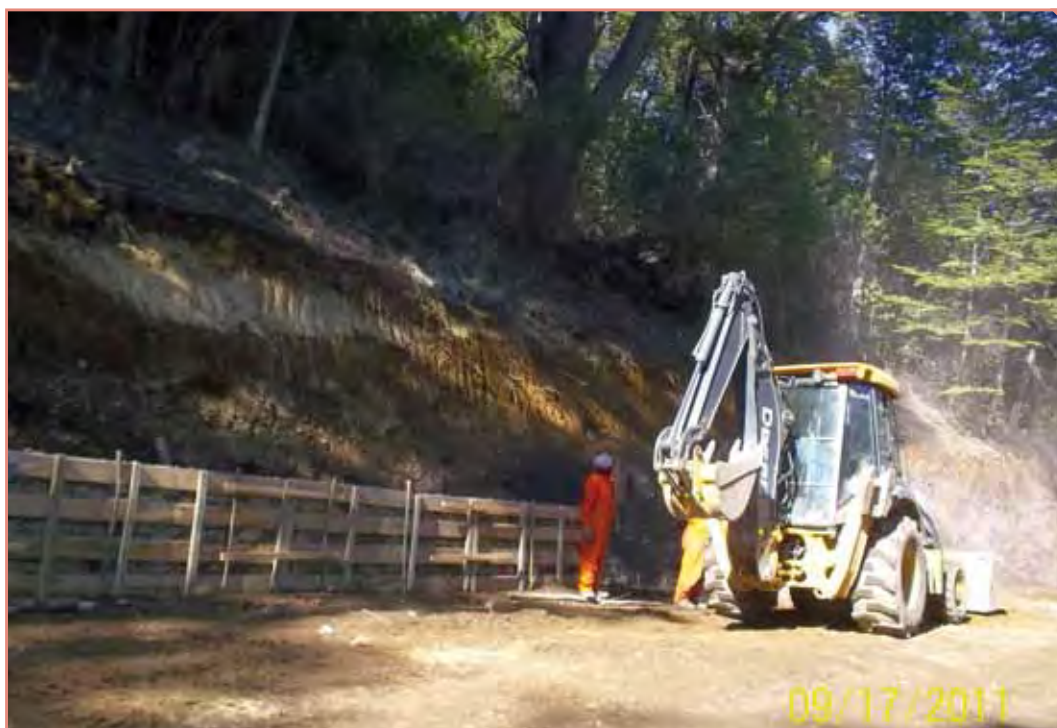
Figura 21. Talud fijado con gaviones y trozas de madera.
